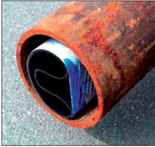
Рис. 15. Труба «Compact SlimLiner», размещенная в восстанавливаемом трубопроводе
