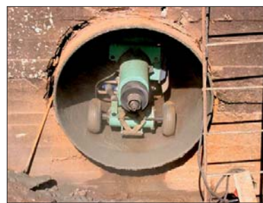
Рис. 4. Агрегат для нанесения цементно-песчаного покрытия центробежным набрызгом
