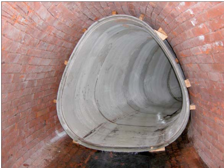
Рис. 1. Монтаж композитных стеклопластиковых модулей
