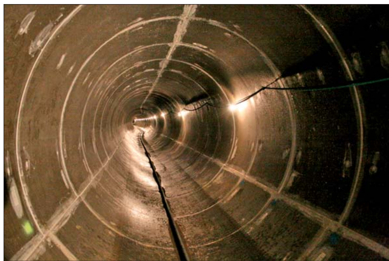
Рис. 4. Участок Ново-Люберецкого канала, восстановленный полимербетонными модулями
