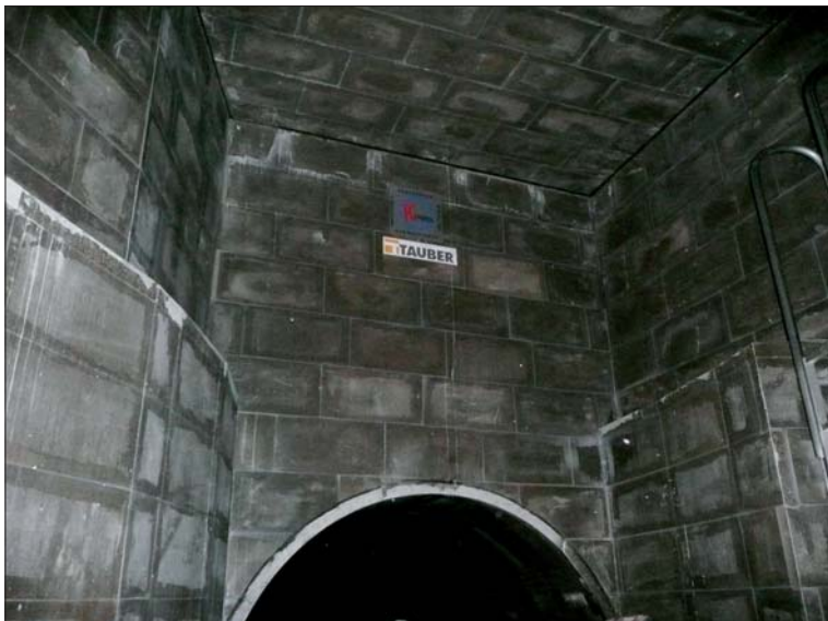
Рис. 5. Восстановленная камера Ново-Люберецкого канала
