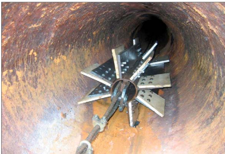
Рис. 7. Снаряд для прочистки дюкера
