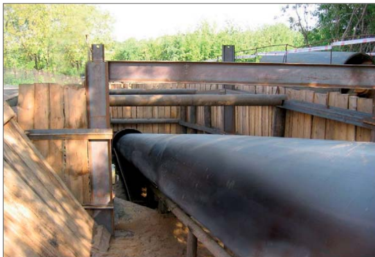
Рис. 8. Протаскивание полиэтиленового трубопровода
