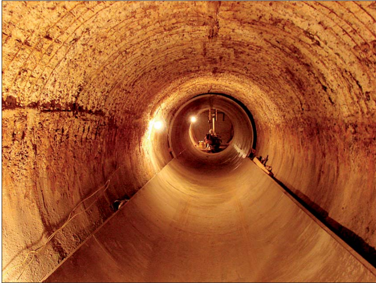
Рис. 3. Монтаж полимербетонных модулей
