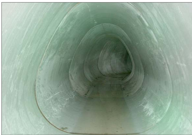
Рис. 2. Участок Люблинского канала, восстановленный стеклопластиковыми модулями
