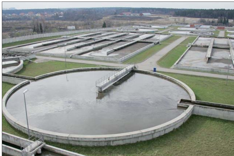
Рис. 1. Панорама Зеленоградских очистных сооружений
