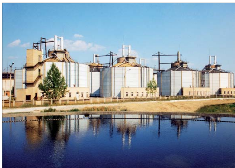
Рис. 6. Метантенки Ново-Люберецких очистных сооружений
