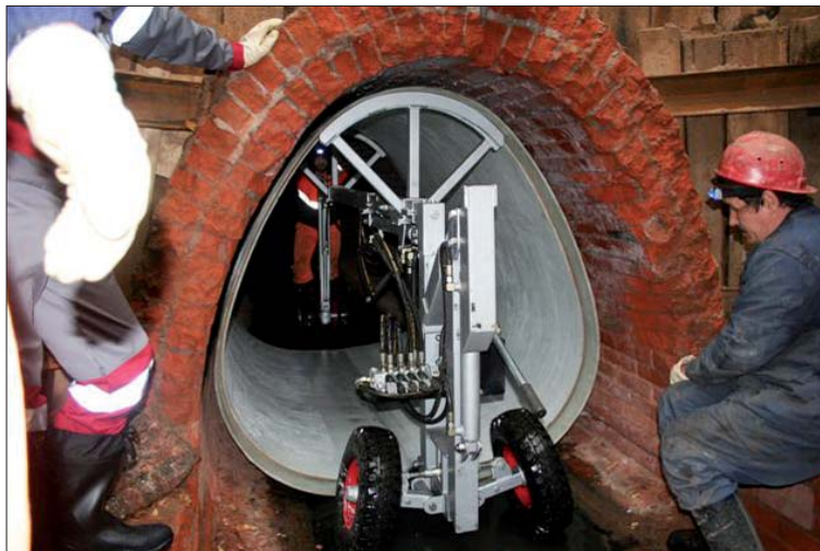
Рис. 7. Монтаж полимерных стеклопластиковых модулей в канализационном канале
