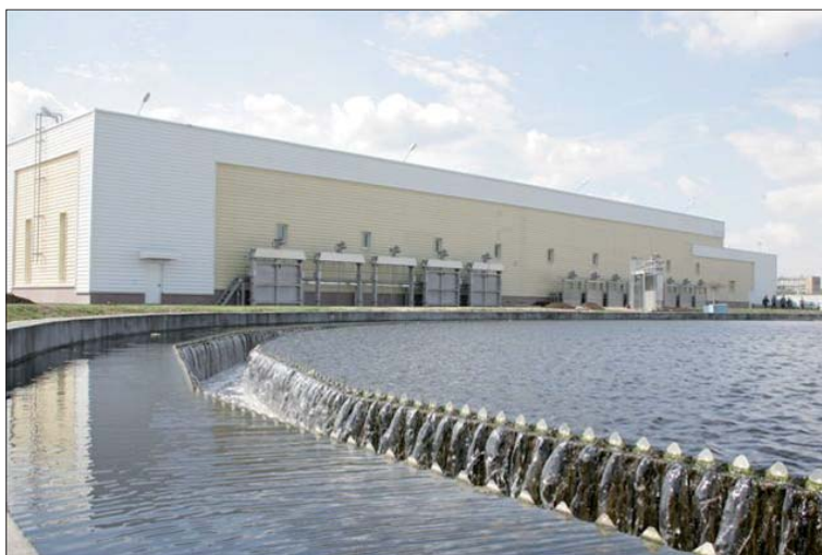
Рис. 4. Блок УФ-обеззараживания на Люберецких очистных сооружениях
