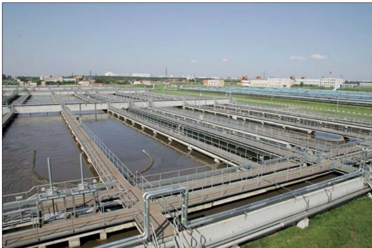
Рис. 3. Блок удаления биогенных элементов на Люберецких очистных сооружениях
